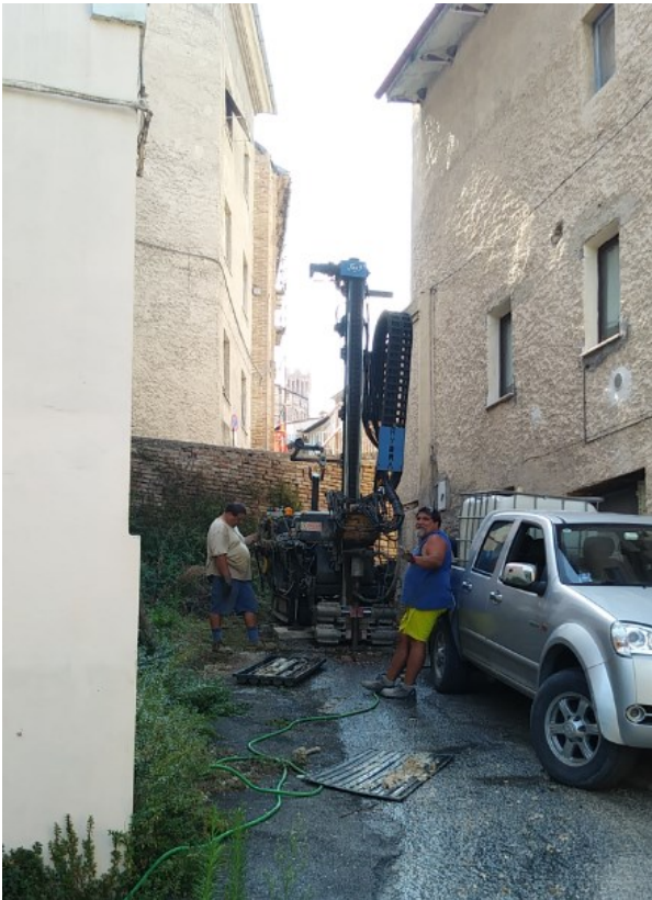
Esecuzione sondaggio stratigrafico a c.c.
