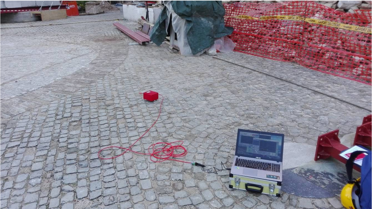
Foto 36 – Acquisizione di segnale HVSR.
