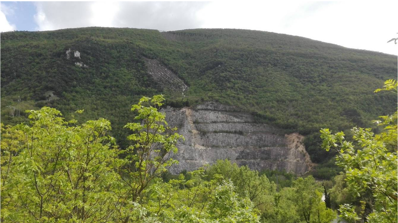
Foto 6 – Affioramento di Calcarea Massiccio nel Monte Nerone in corrispondenza della cava dismessa tra le località Bistocco e Campolarzo (Comune di Camerino), nel versante Nord di Monte Fiungo.
