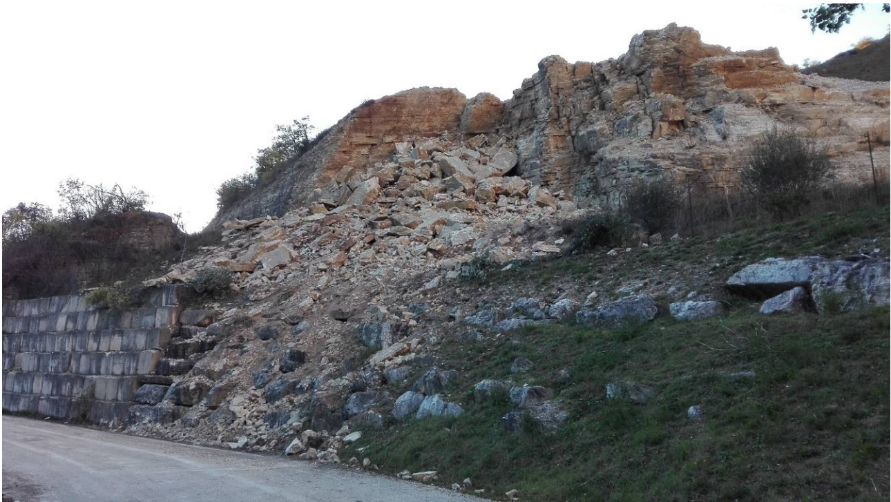
Foto 4 – Crollo di pezzame calcareo e siliceo, appartenente ai Calcari diasprini, in località Bistocco.
