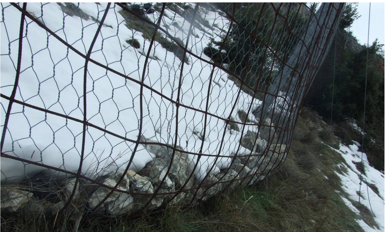
Foto 3 – Pezzame calcareo intercettato dalle barriere paramassi poste sopra l'abitato di Bistocco.
