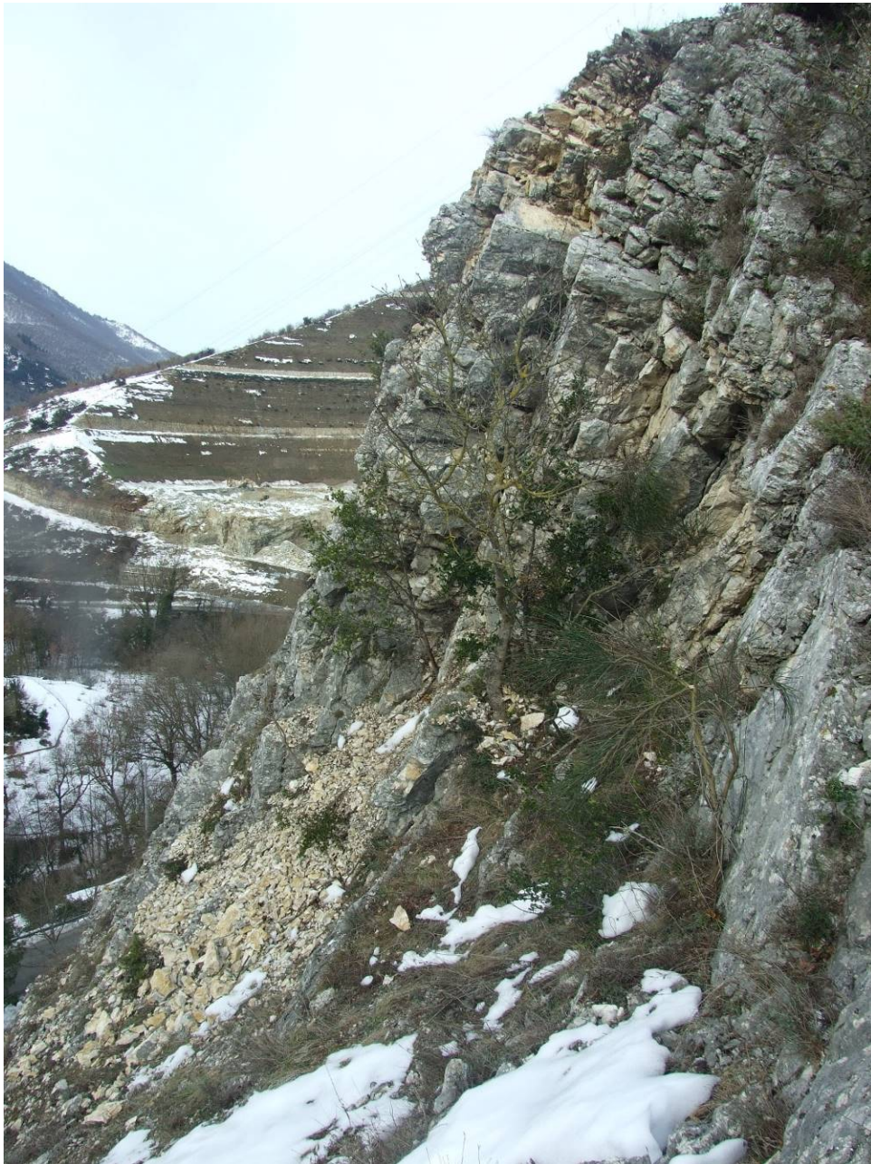
Foto 1 – Distaccamento di materiale dalla Maiolica a seguito dell'evento sismico del 30/10/2016.
