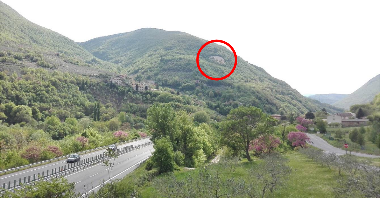
Foto 5 - Frana di tipo scorrimento traslativo al di sopra della centrale idroelettrica di Valcimarra.
