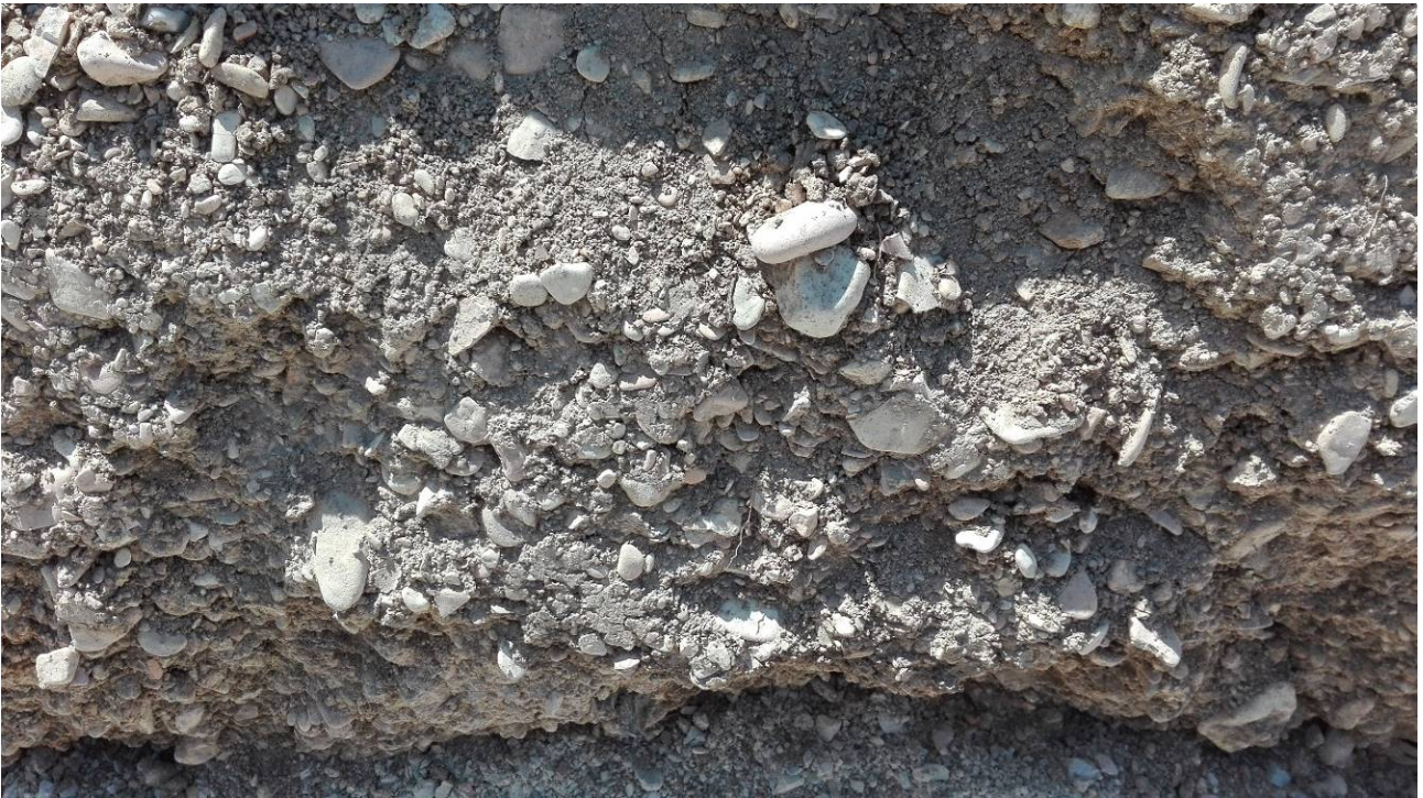
Foto 29 – Ghiaie limose (GMtf) affiorate durante l'esecuzione degli scavi di sbancamento per la realizzazione dell'area S.A.E.
