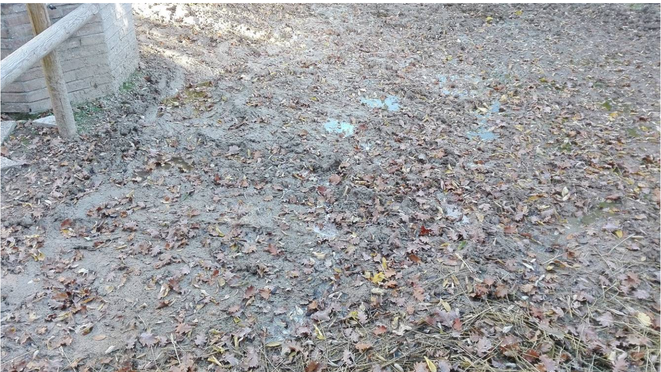
Foto 37 – Emissione fluida verificatasi a seguito dell'evento sismico del 30/10/2016 in via Aldo Moro.
