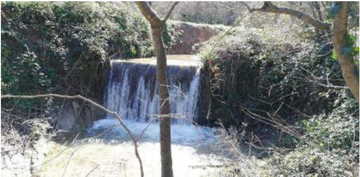
Foto 13 – Briglia all'interno dell'alveo del Fosso delle Conce.
