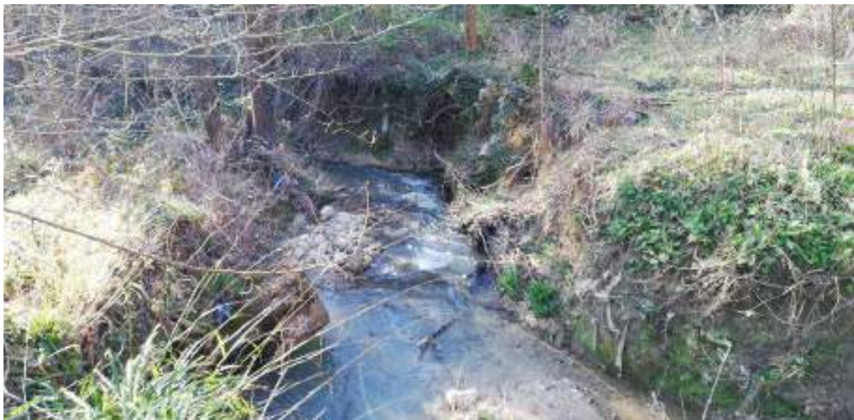
Foto 11 – Erosione laterale ad opera del Fosso delle Conce.
