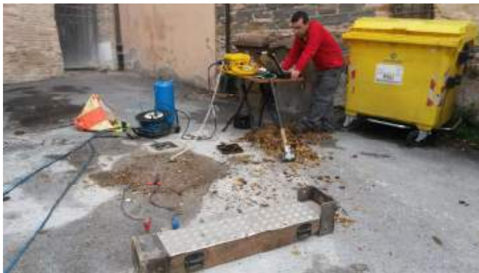
Foto - Sito di durante l'esecuzione della prova
