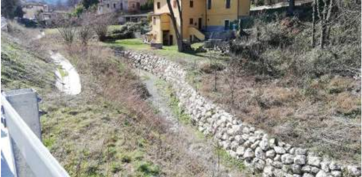
Foto 12 – Opere di difesa spondale con massi ciclopici in corrispondenza del tratto di bretella stradale realizzato.
