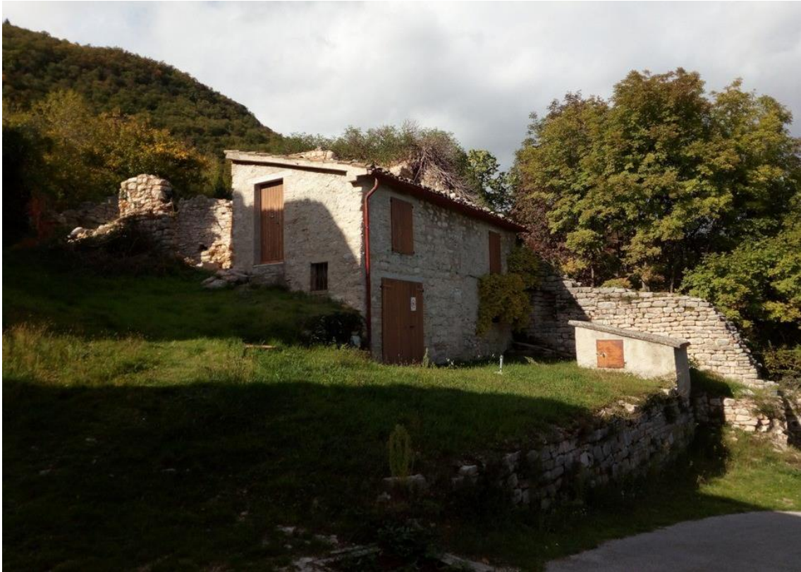
FOTO 1 – VISTA SUD/EST – STATO ATTUALE
