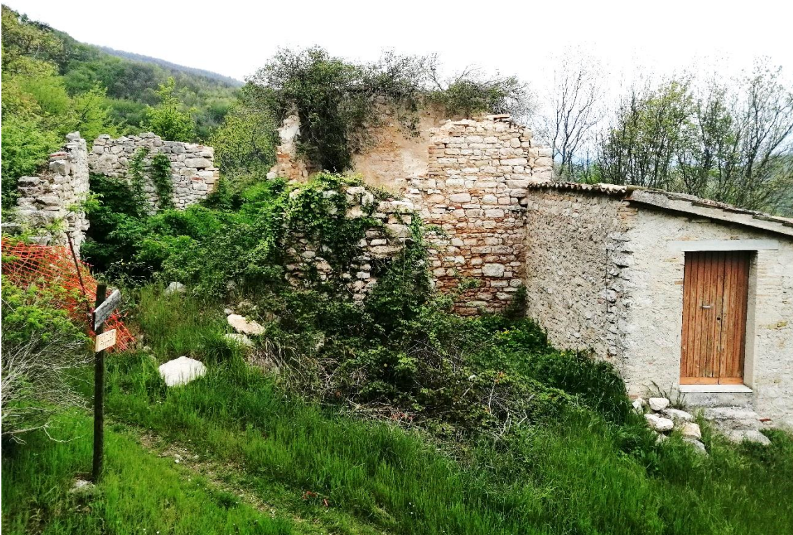
FOTO 2 – VISTA SUD – STATO ATTUALE
