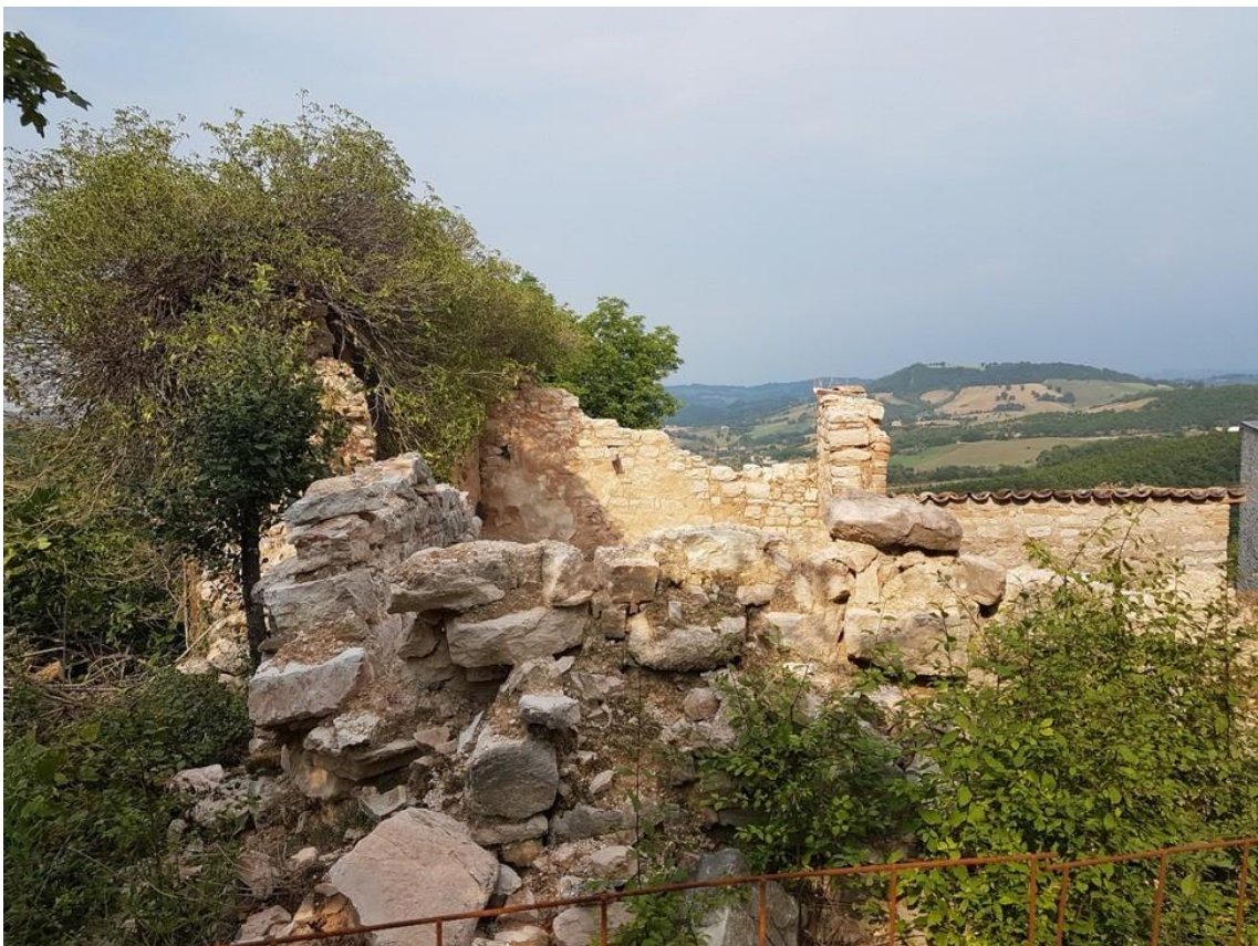
FOTO 4 – VISTA OVEST – STATO ATTUALE
