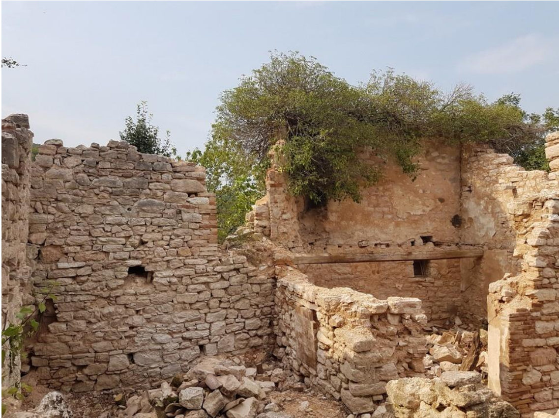
FOTO 3 – VISTA SUD – STATO ATTUALE
